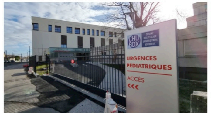
Les urgences pédiatriques se feront par un accès rue de la Pelouse de Douet située avant l'arrêt du tramway direction Bordeaux
