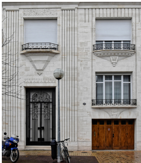
53 avenue du Parc de Lescure, un immeuble de style Art déco parmi plus d'une centaine construits dans ce lotissement dans l'entre-deux-guerres.
